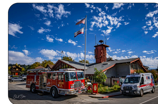
Estacion de Bomberos del Distrito y Vehiculos de Respuesta a Emergencias
